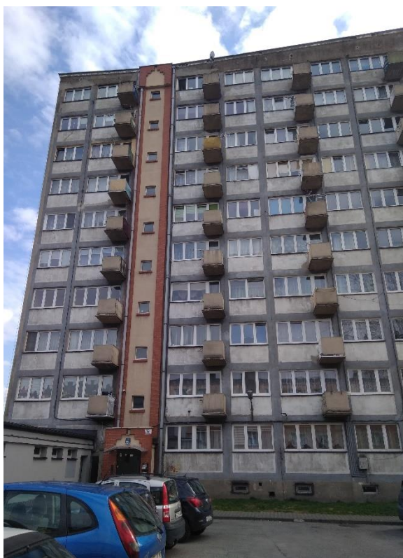
Fot.3. Elewacja zachodnia
