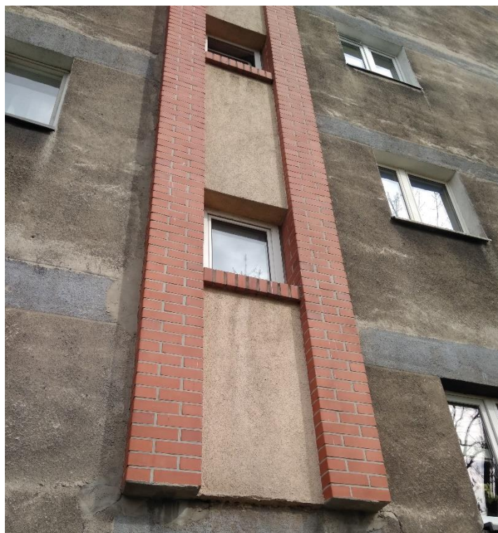
Fot.5. Część elewacji szczytowej
