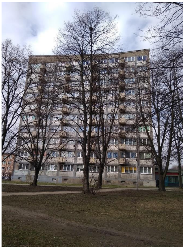
Fot.4. Elewacja wschodnia
