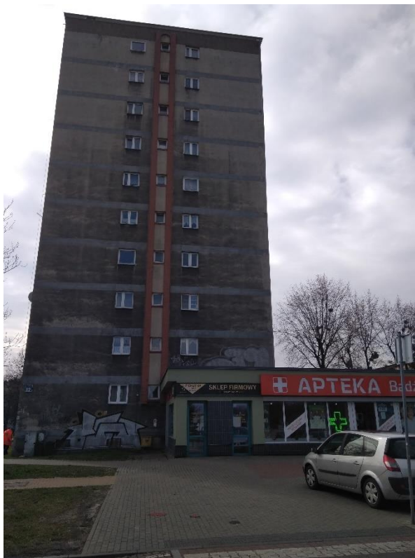
Fot.2. Elewacja północna
