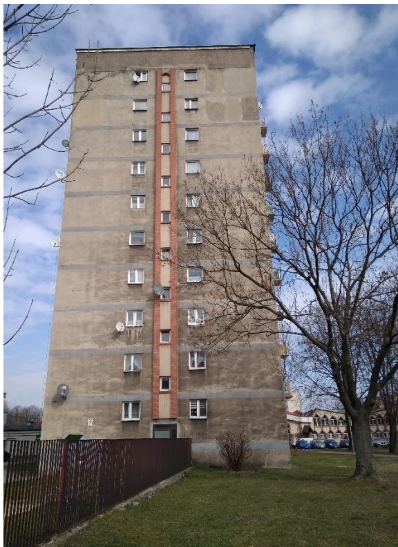
Fot.1. Elewacja południowa
