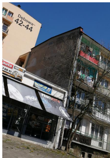
Fot.4. Elewacja północno-zachodnia
