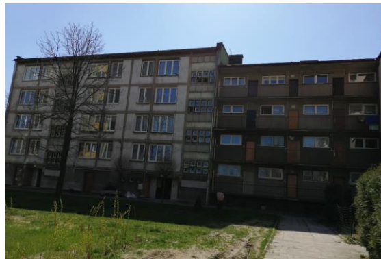
Fot.2. Elewacja północno-wschodnia
