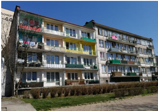
Fot.1. Elewacja południowo-zachodnia
