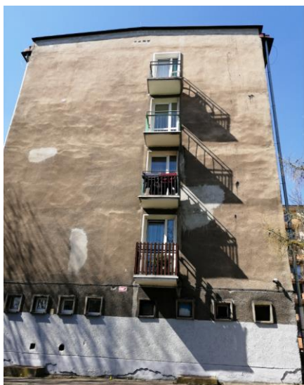
Fot.3. Elewacja południowo-wschodnia
