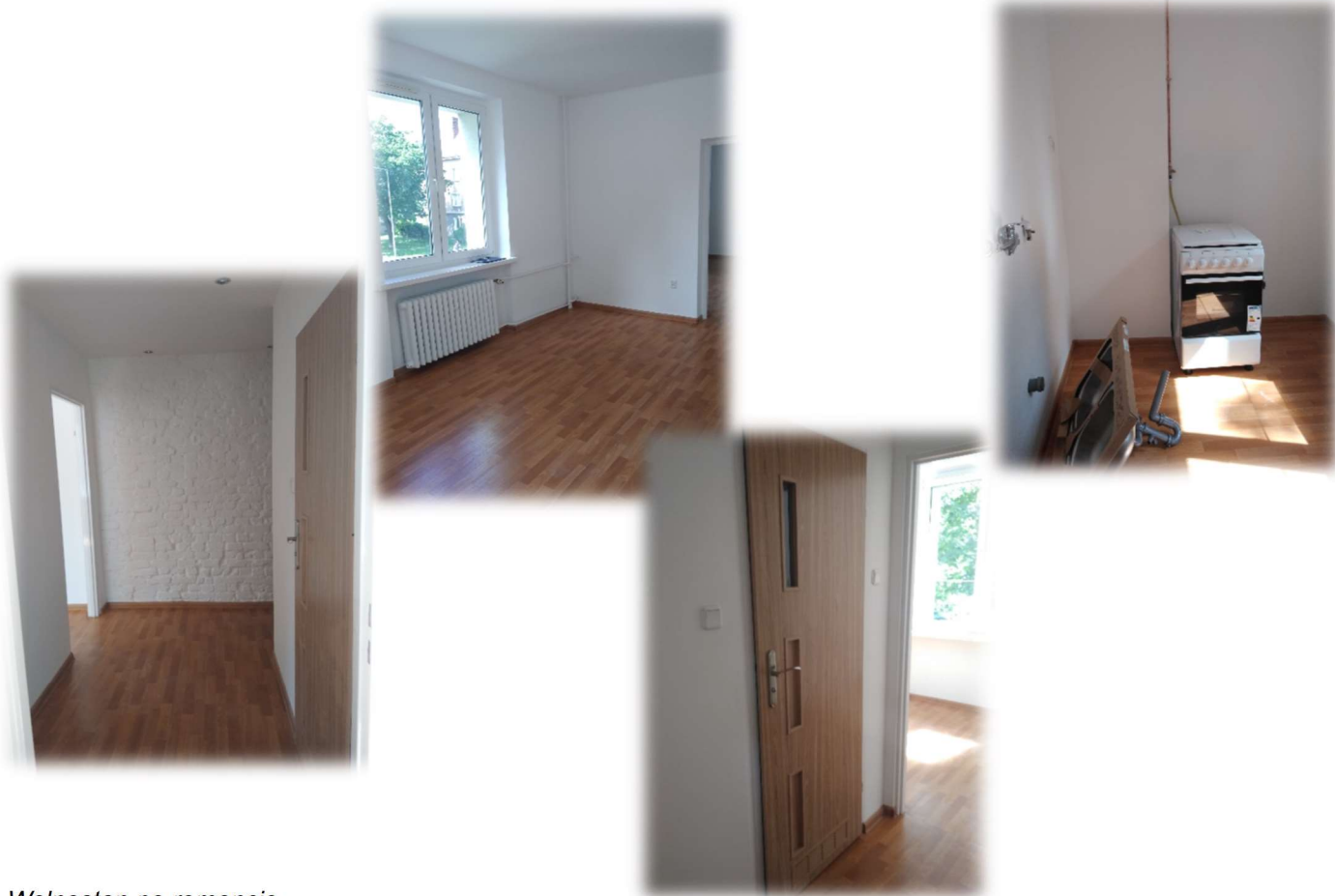
Wolnostan po remoncie
