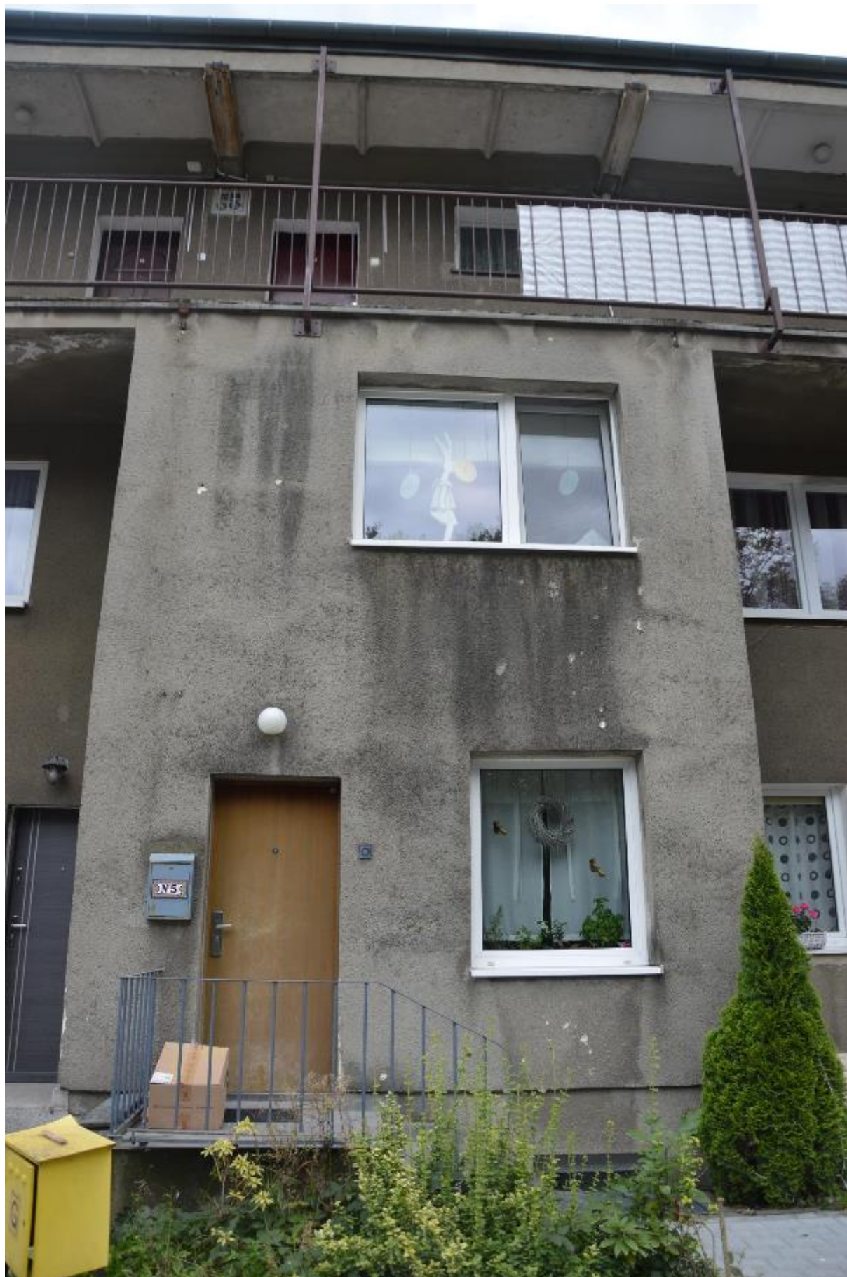
Fot. nr 8. Silne zabrudzenie elewacji. Widoczne ubytki tynku wraz z odsłonięciem materiału termoizolacyjnego (uszkodzenie mechaniczne spowodowane gradem) [1.3]
