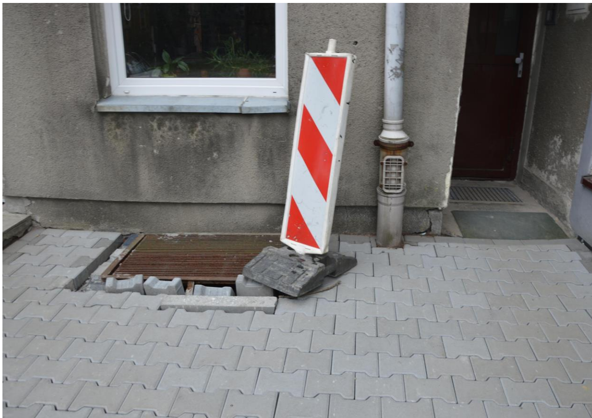
Fot. nr 10. Deformacja podłoża z kostki brukowej w pobliżu zsypu piwnicznego [1.3]
