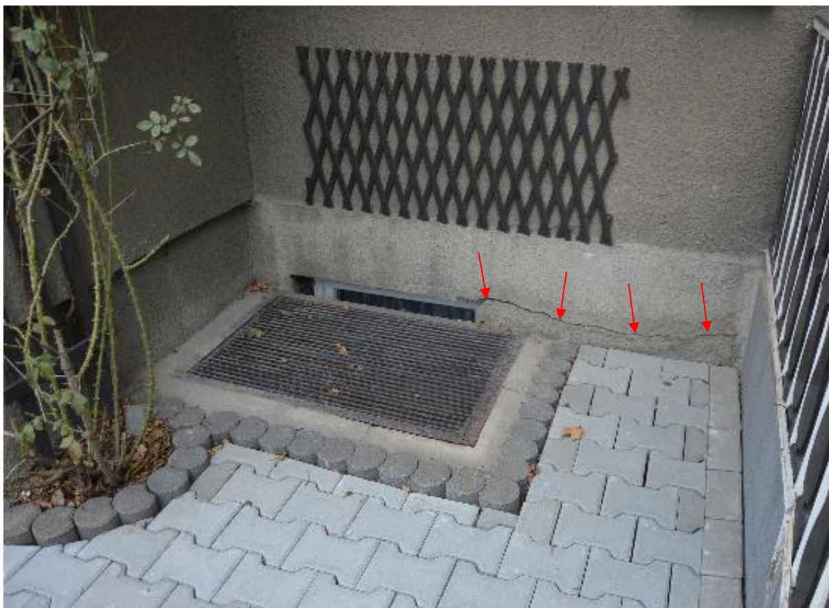
Fot. nr 7. Zarysowanie tynku w strefie przyziemia [1.3]
