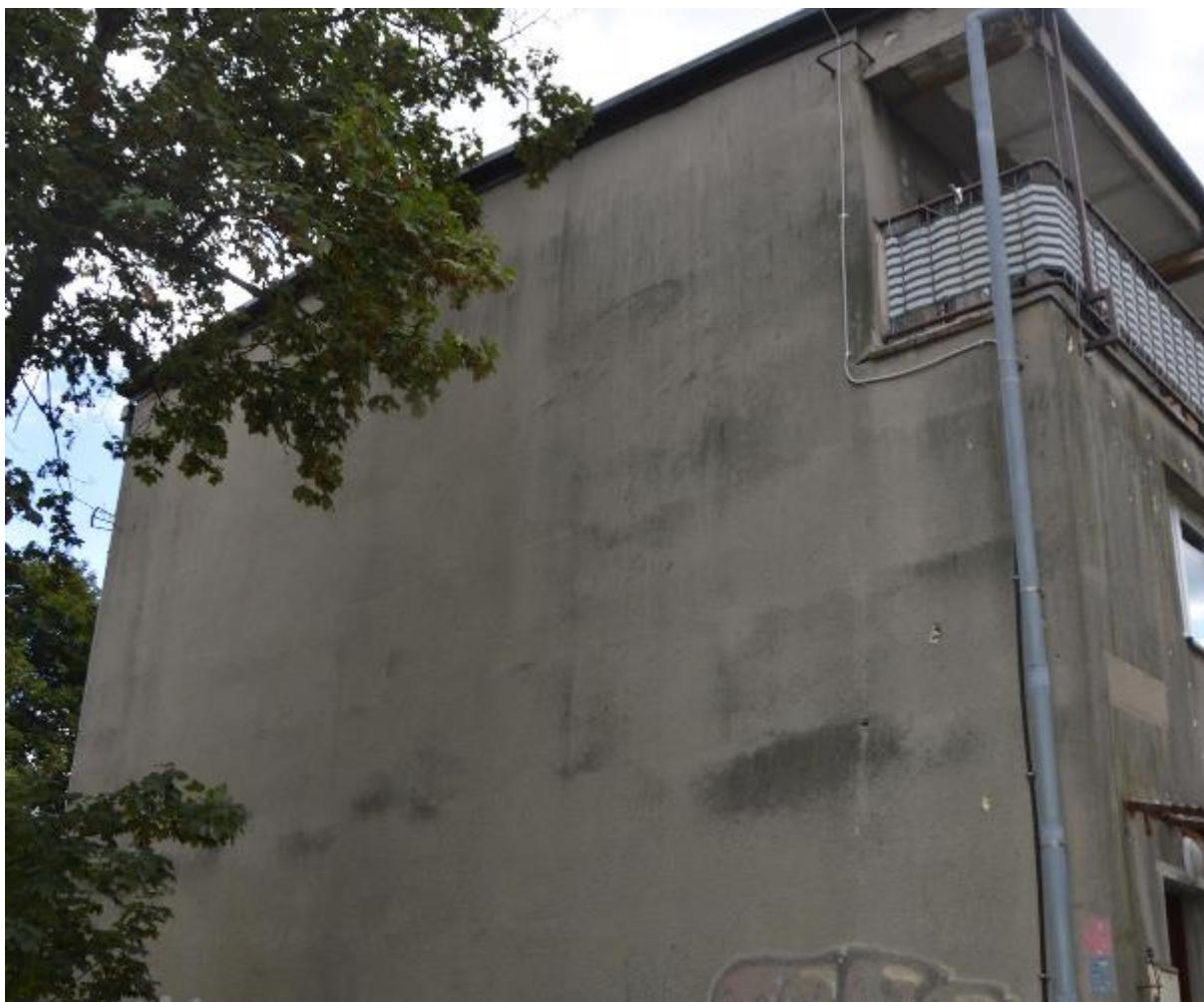
Fot. nr 9. Zabrudzenie elewacji szczytowej. Korozja obróbek blacharskich [1.3]
