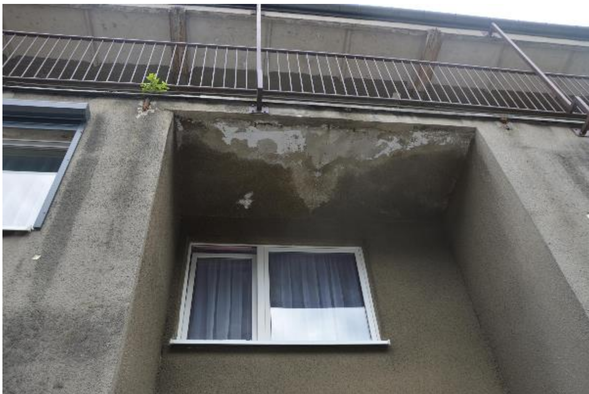
Fot. nr 6. Rozległe odspojenie tynku – odsłonięcie zbrojenia płyty galerii [1.3]
