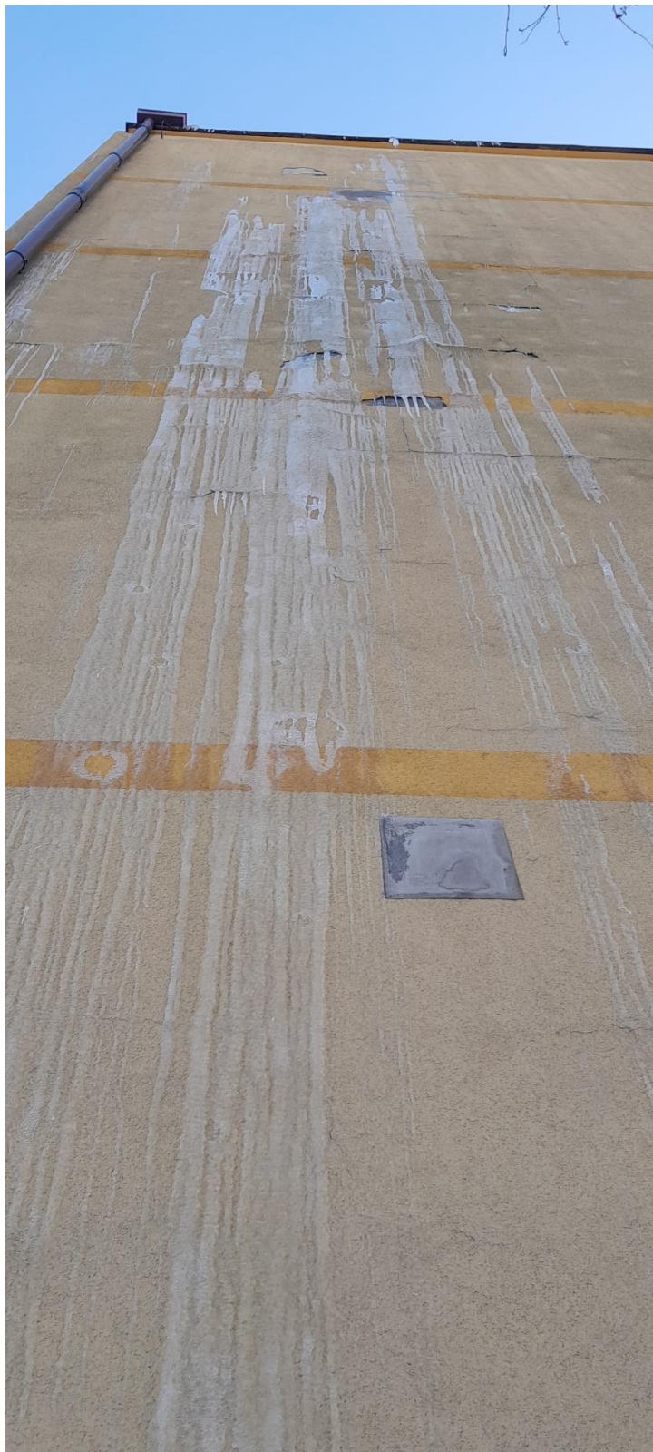
Rysunek 9 Zamarznięte zacieki wody na elewacji
