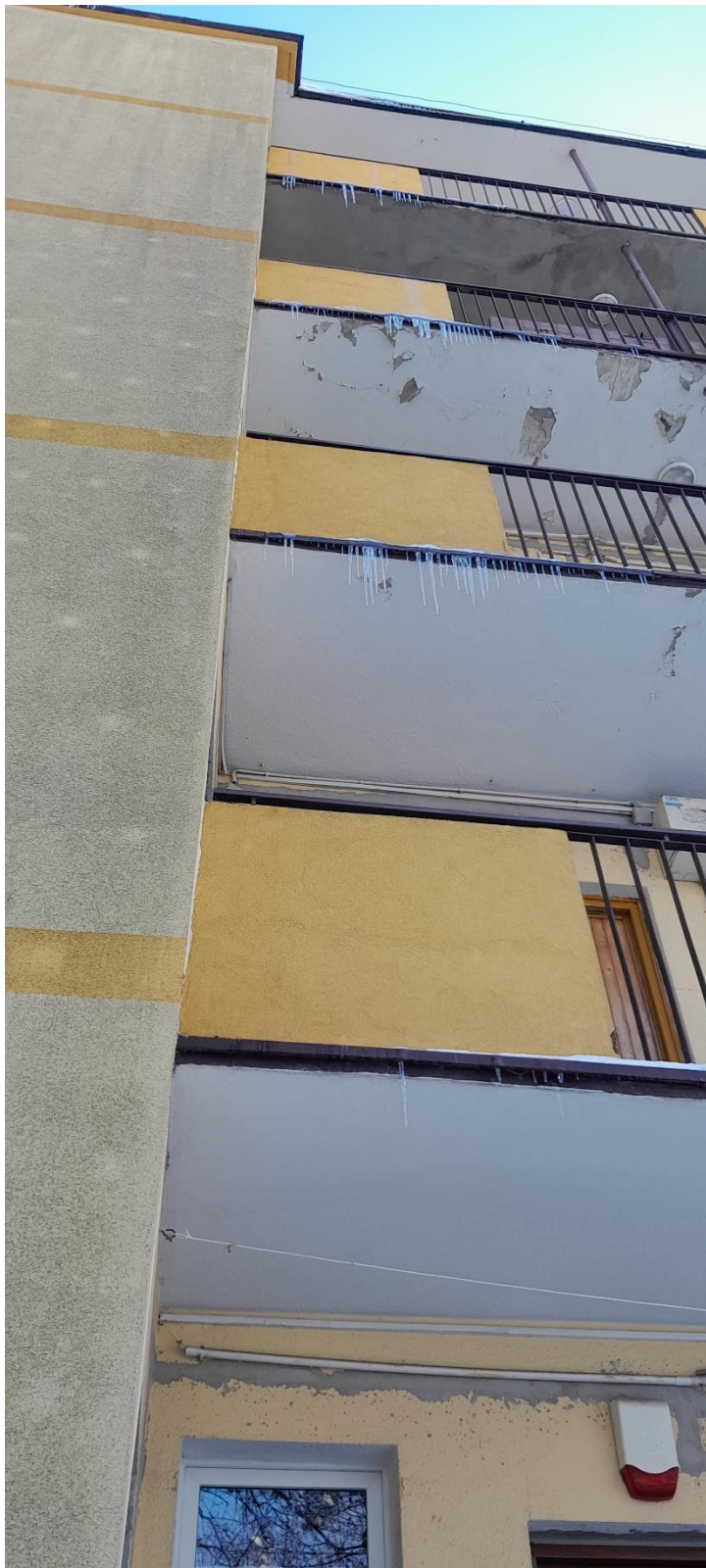
Rysunek 8 Zamarznięte zacieki wody obróbkach galerii
