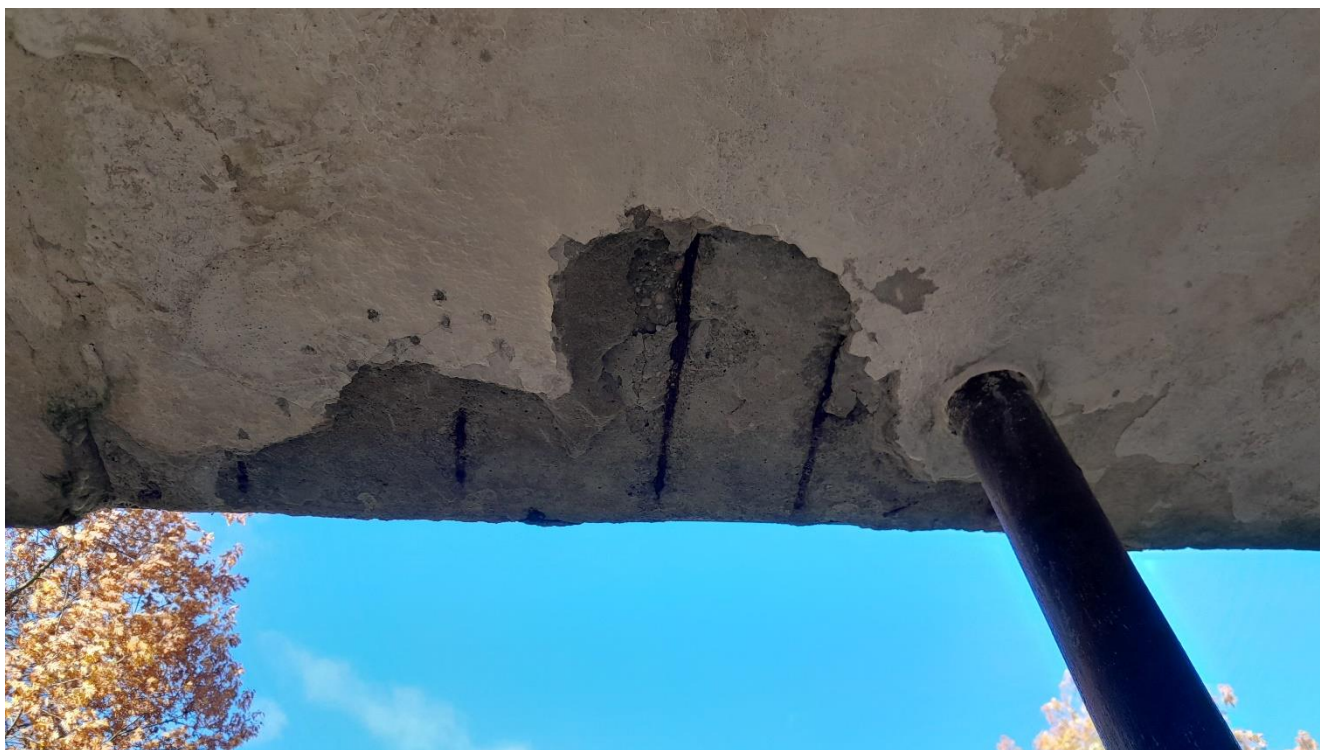
Rysunek 17 Zniszczenia spodów galerii i balkonów
