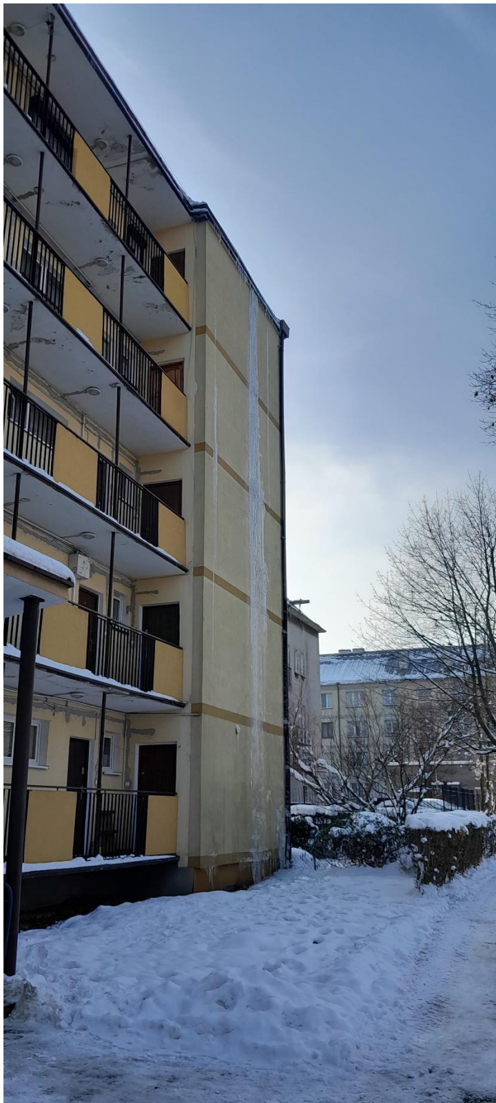
Rysunek 7 Zamarznięte zacieki wody na elewacji
