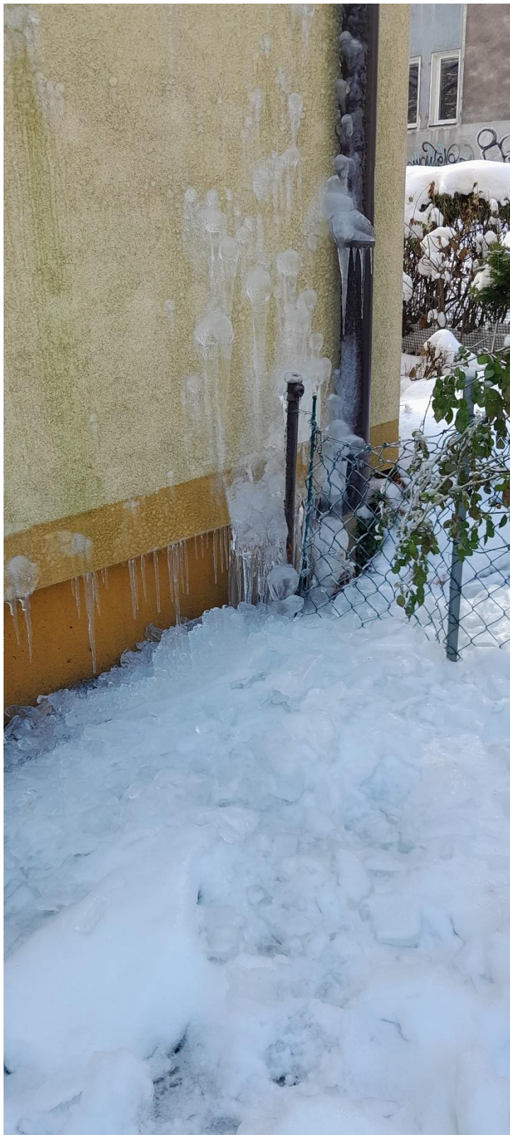
Rysunek 12 Zamarznięta rura spustowa
