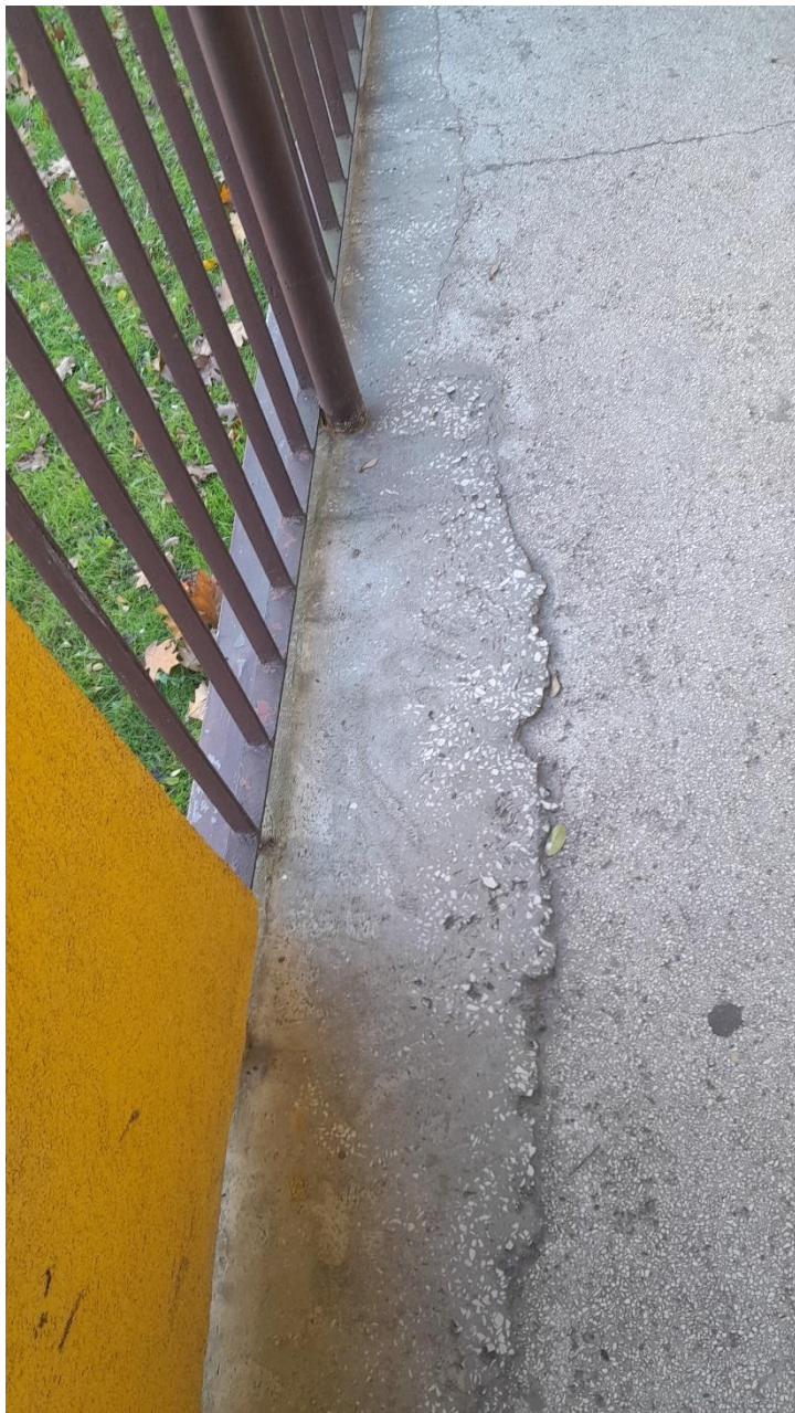
Rysunek 15 Spękania wylewki na galeriach i zniszczenia spowodowane wymianą obróbki blacharskiej krawędziowej
