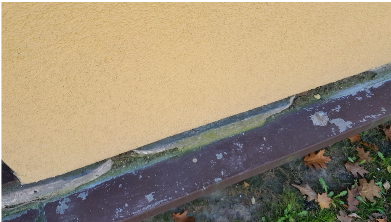
Rysunek 16 Zniszczenia wylewki przy balustradach pełnych
