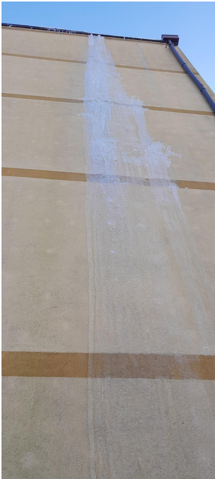
Rysunek 10 Zamarznięte zacieki wody na elewacji
