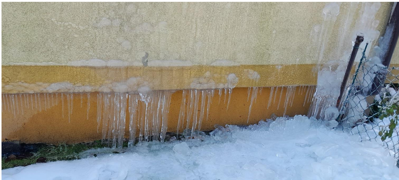
Rysunek 13 Zamarznięta woda na elewacji
