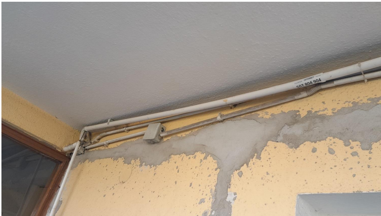
Rysunek 18 Instalacje na galeriach wymagające uporządkowania
