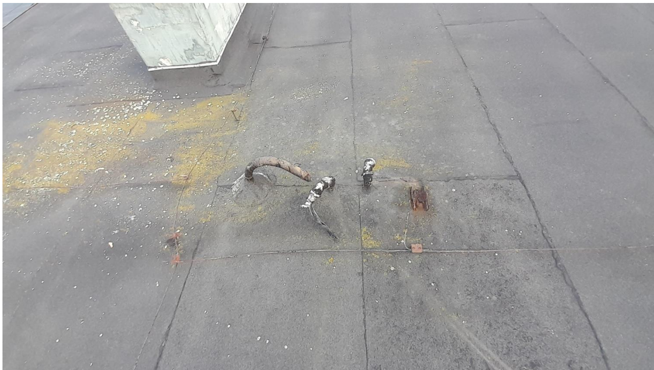
Rysunek 24 Połącze dachowa i pozostałości instalacji klimatyzacyjnej
