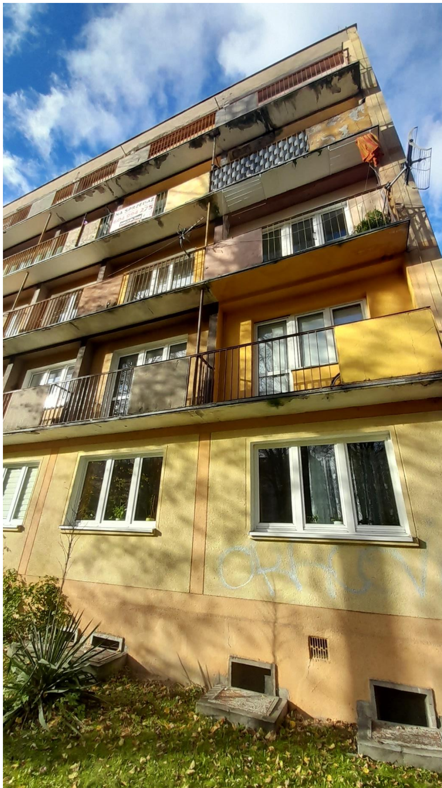
Rysunek 5 Zacieki i ubytki betonu na płytach balkonowych
