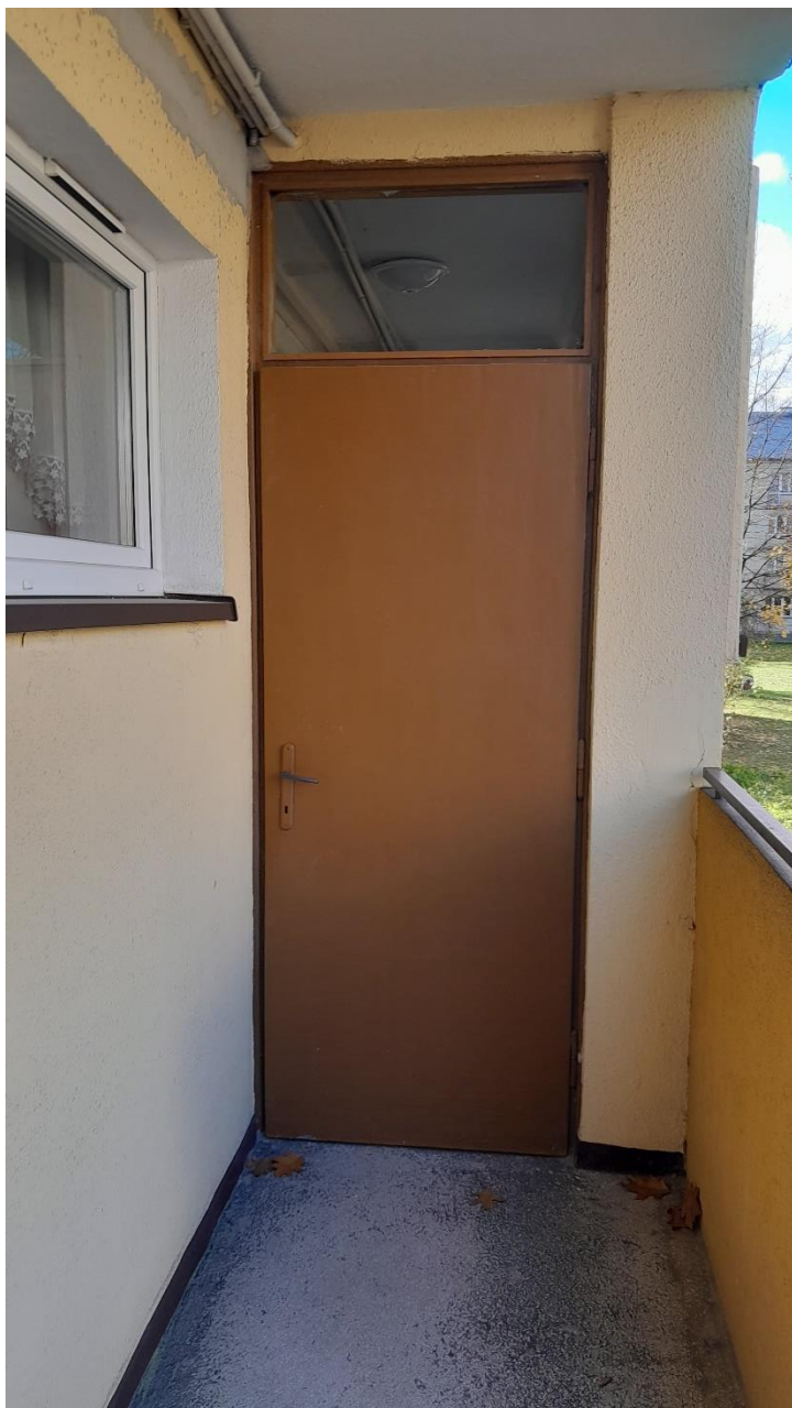
Rysunek 21 Drzwi z do klatki schodowej do wymiany wraz z замуrowaniem naświetla górnego
