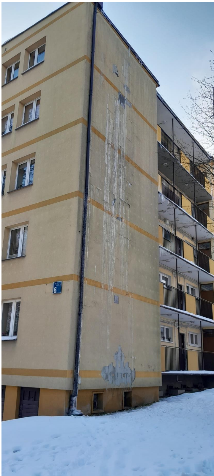
Rysunek 6 Zamarznięte zacieki wody na elewacji
