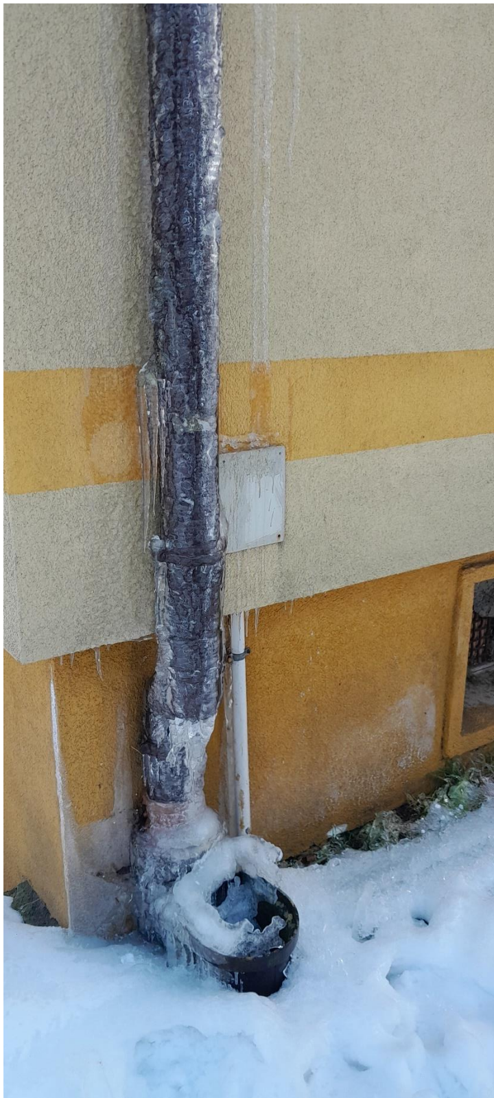
Rysunek 11 Zamarznięta rura spustowa
