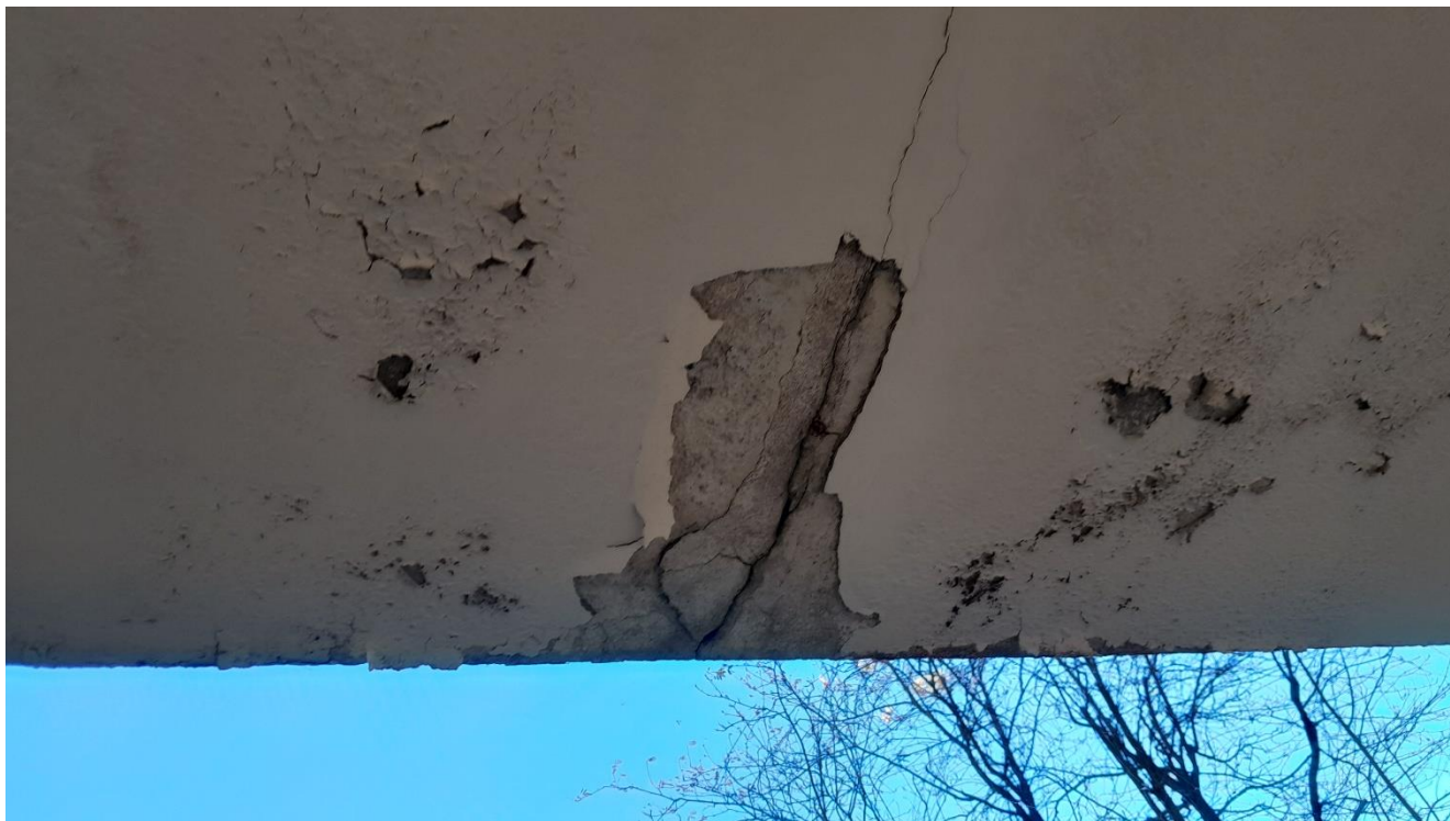
Rysunek 20 Zniszczenia spodów galerii i balkonów
