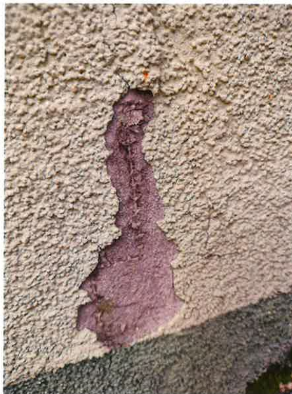
: Elewacja południowa przy balkonach
