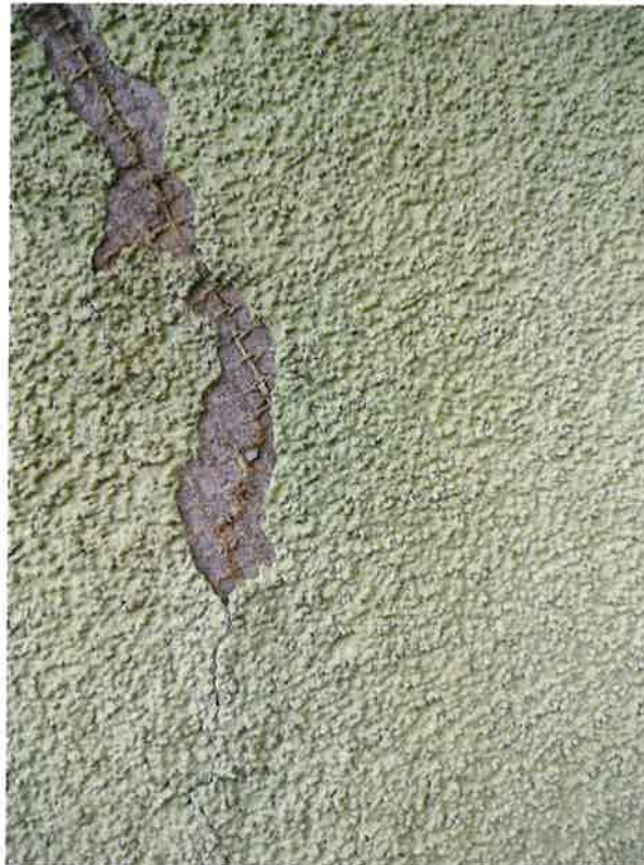
Elewacja południowa przy balkonach
