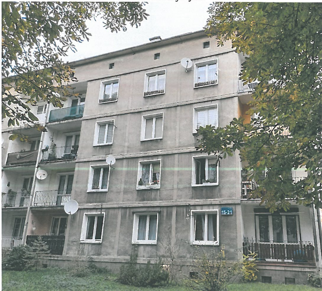
Fot.11 Elewacja tylna
