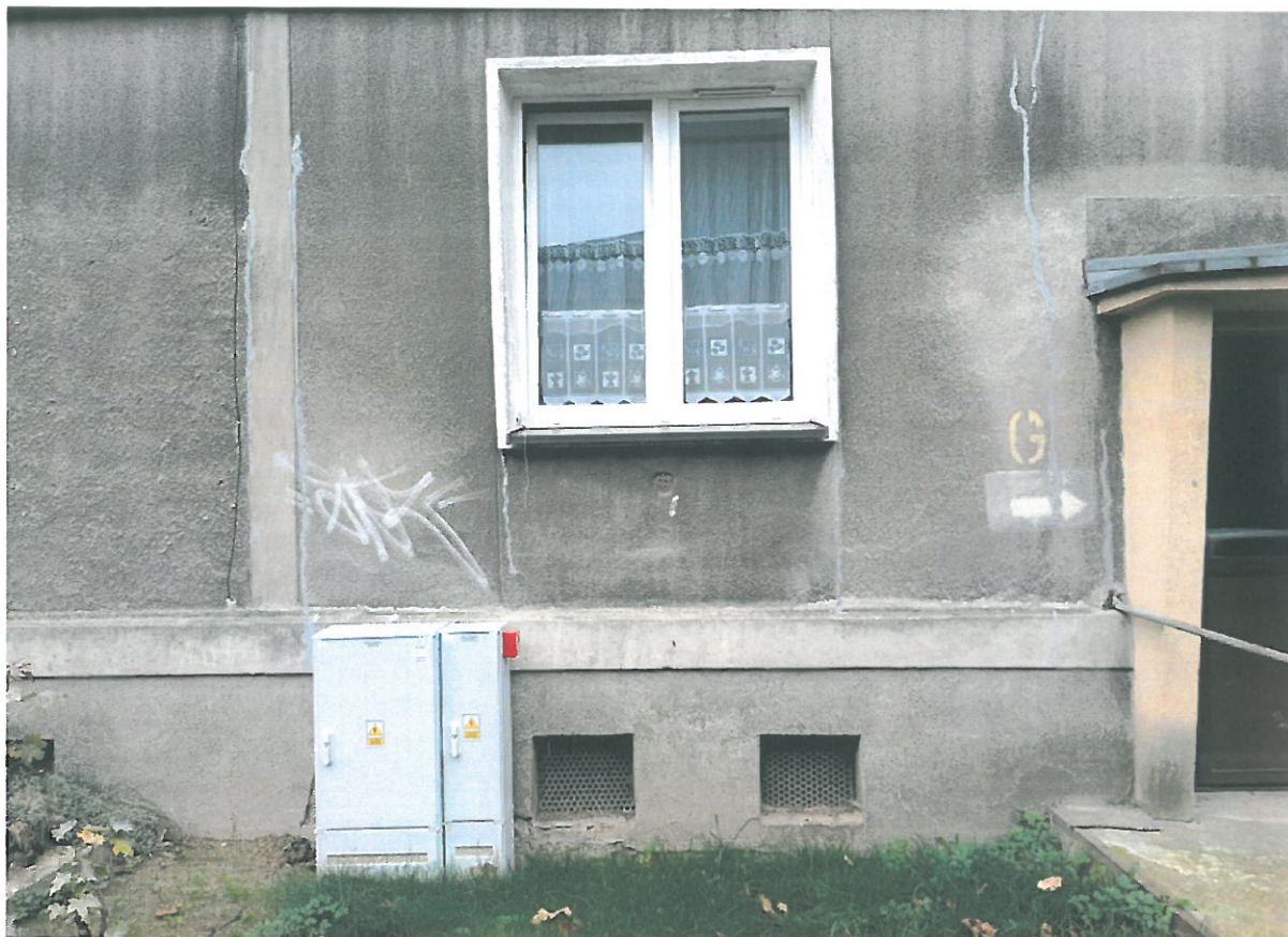
Fot.5 Elewacja frontowa – strefa przyziemi
