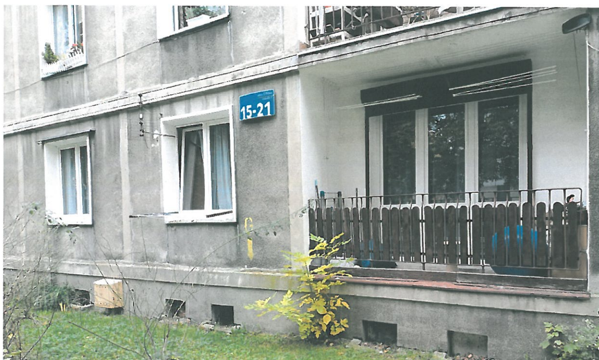
Fot.12 Elewacja tylna- strefa przyziemia
