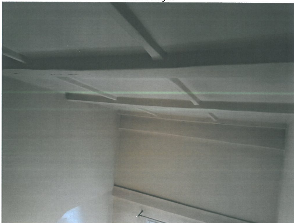
Fot.17 Sufit nad klatką schodową
