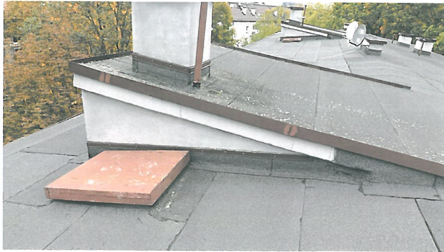
Fot.15 Lukarna dachowa
