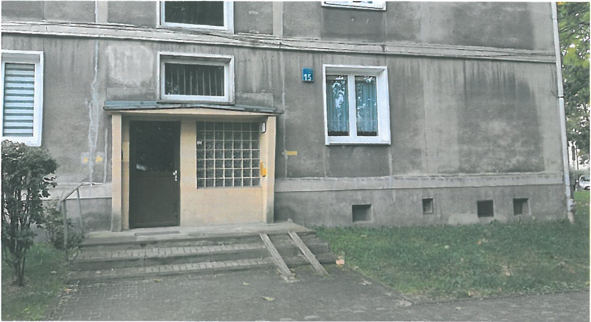
Fot.3 Elewacja frontowa - wejście
