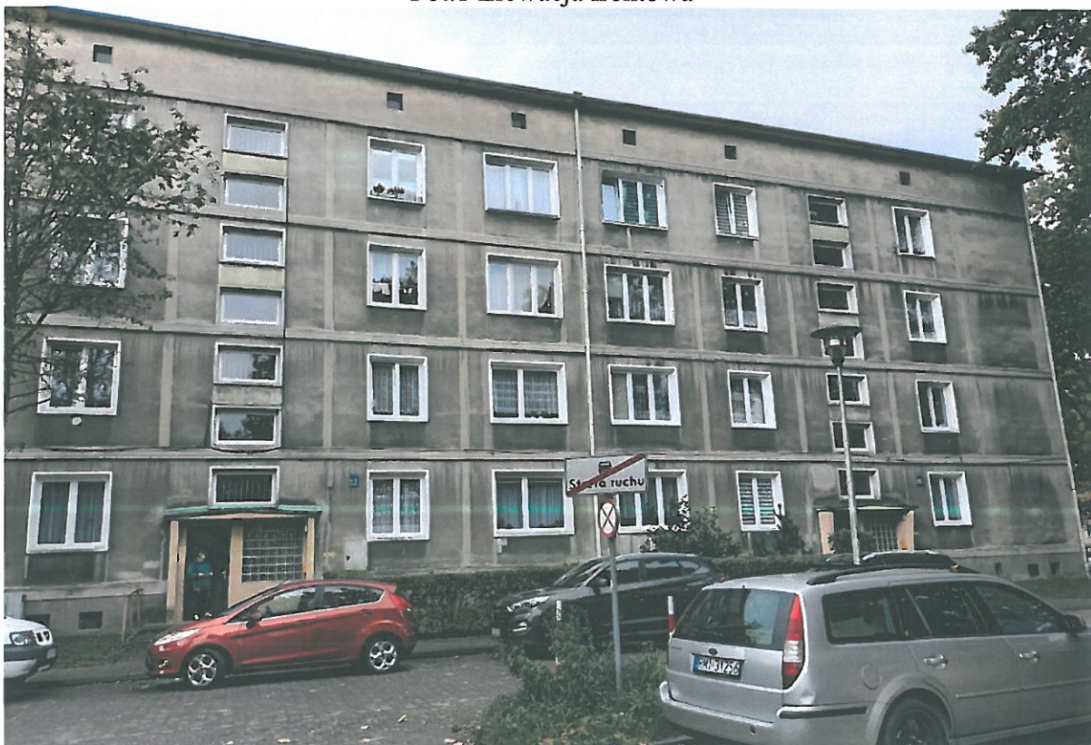
Fot.2 Elewacja frontowa
