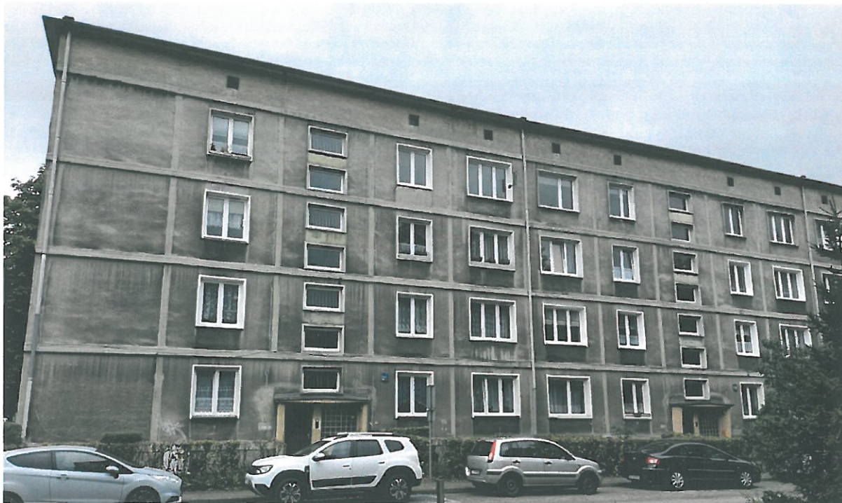
Fot.1 Elewacja frontowa
