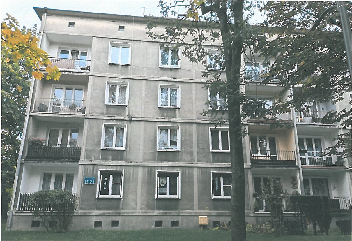
Fot.10 Elewacja tylna
