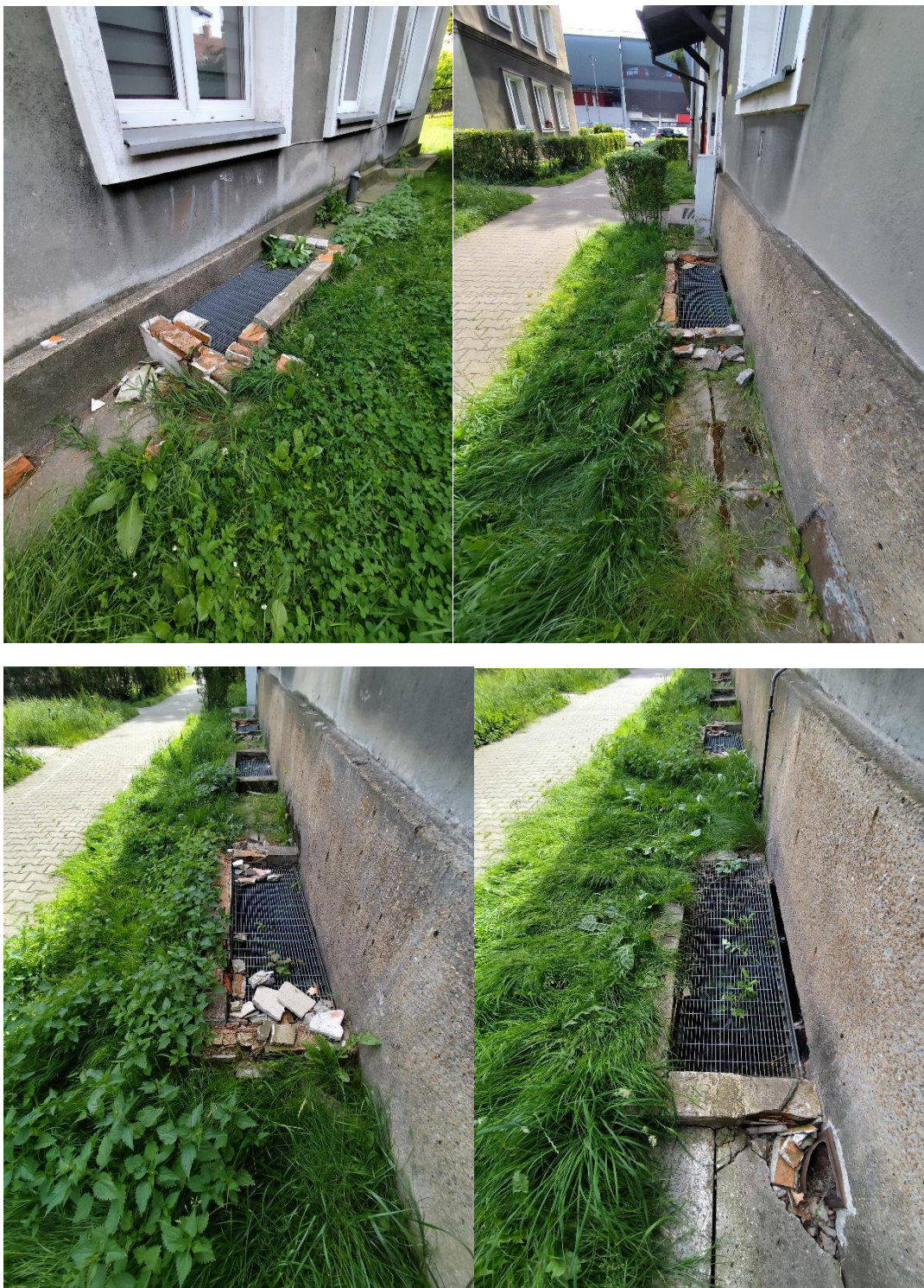
Tychy ul. Baziowa 5- 7 naprawa naświetli
