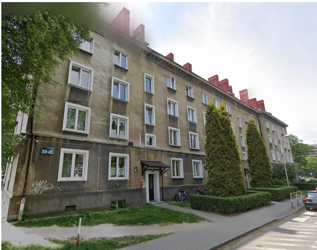
Fot. 2 – elewacja frontowa budynku od strony ul. Brzozowej
