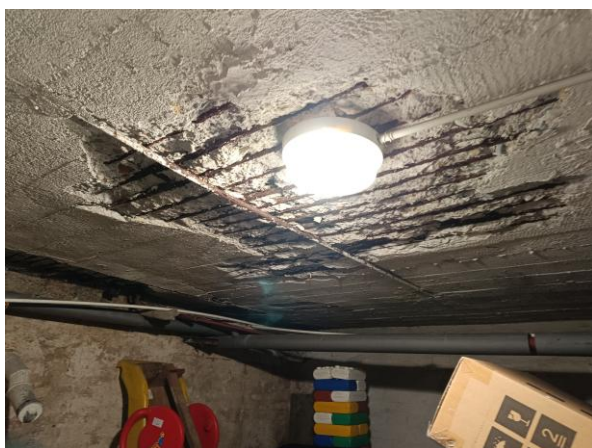
Fot.3 – Ubytek w środku przęsła. Odspojona otulina betonowa, widoczna korozja zbrojenia.
