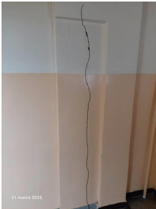
Rys. 3. Zarysowania tynków w strefie połączeń z segmentami budynku
