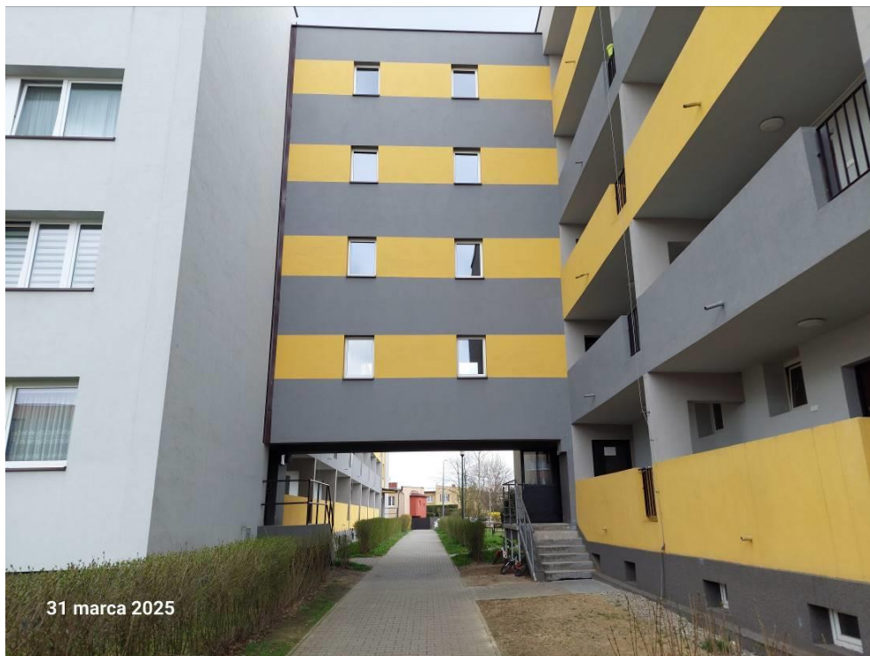
Rys. 1. Widok budynku przy ul. Dunikowskiego 38÷42 z łącznikiem
