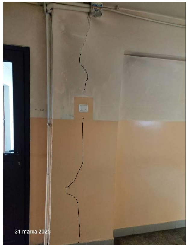
Rys. 3. Zarysowania tynków w strefie połączeń z segmentami budynku
