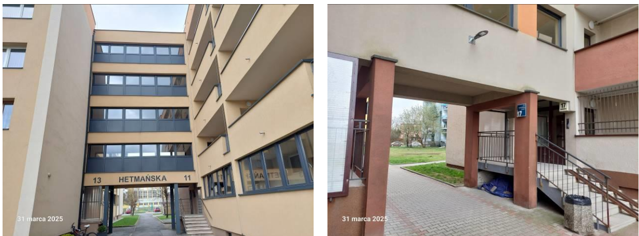
Rys. 13. Profilaktyczne zabezpieczenia łączników galeriowców na osiedlu
