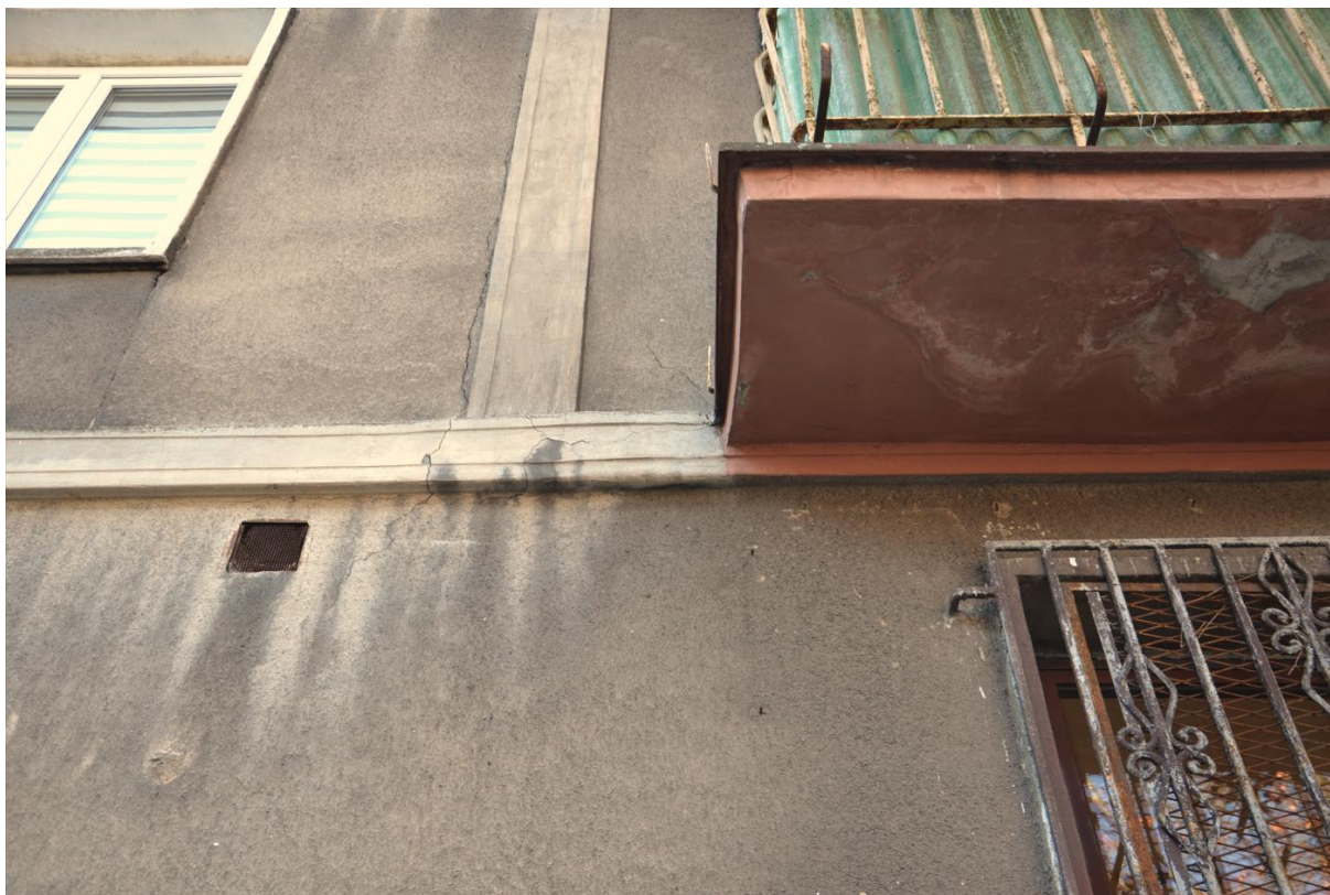
Fot. nr 17. Fragment elewacji północno – wschodniej – pęknięcia wypraw tynkarskich, ślady zamakania, ubytki i odspojenia tynków na spodzie płyt balkonowej, korozja elementów stalowych balustrady i kraty drzwiowej [1.3.]
