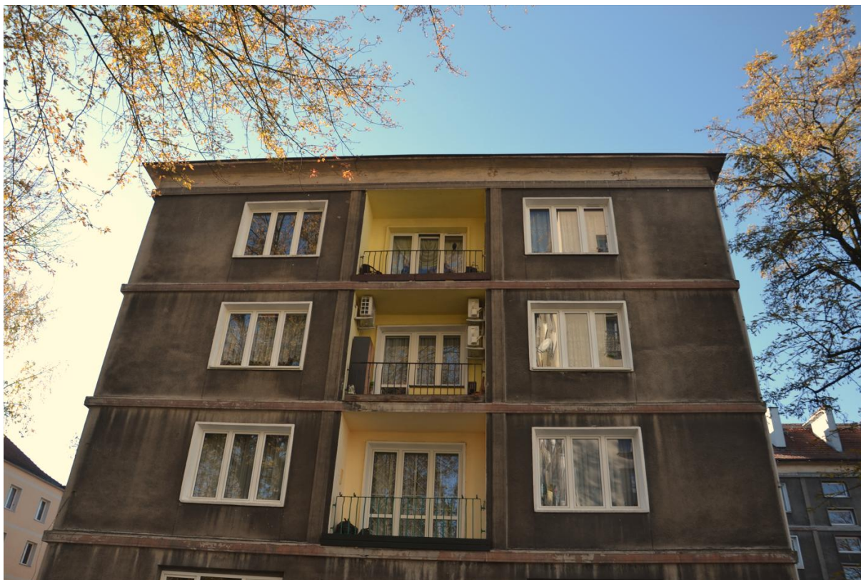
Fot. nr 5. Fragment elewacji północno – wschodniej, widoczne zabrudzenie elewacji, ubytki tynków i powłok malarskich na gzymsach [1.3.]
