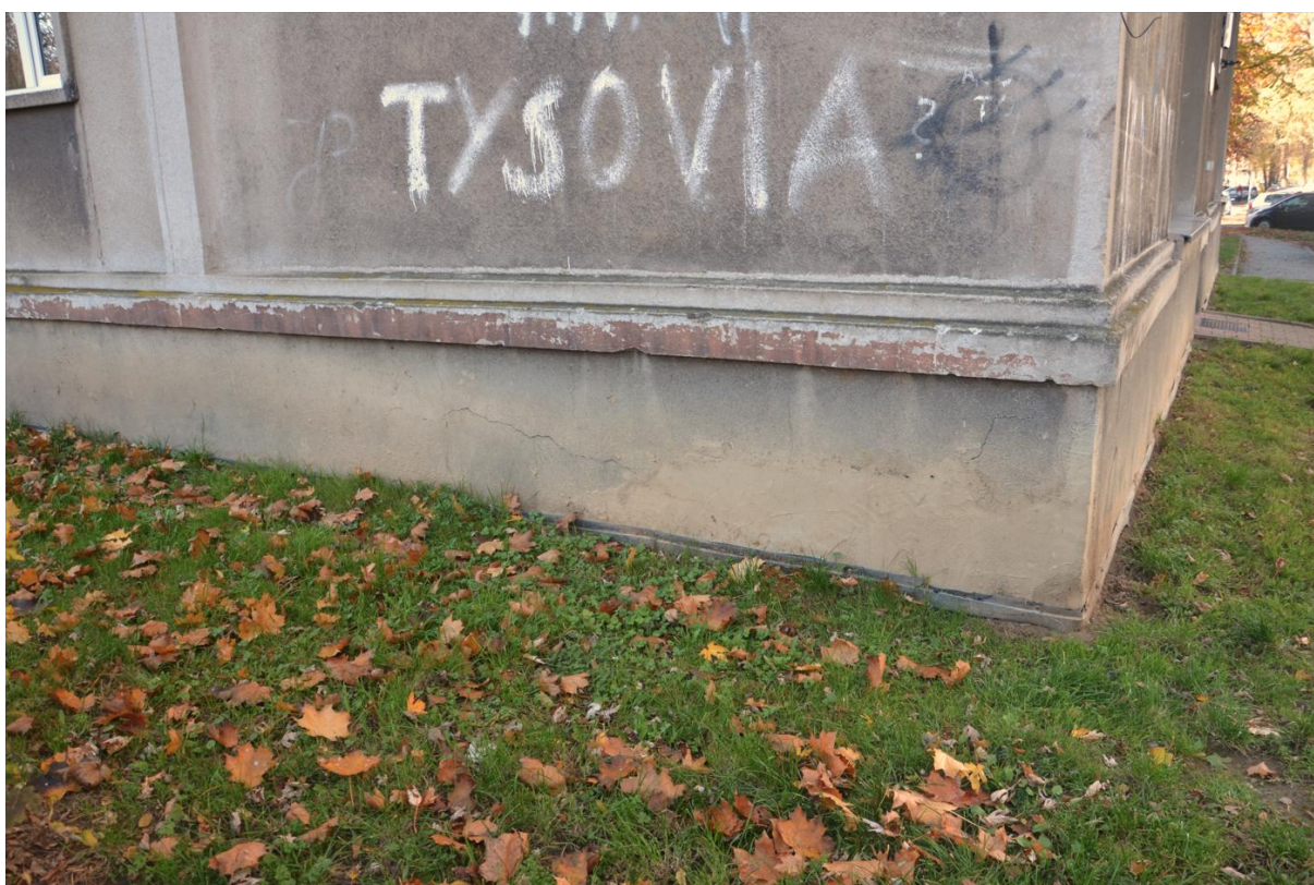
Fot. nr 8. Cokół wschodniego narożnika budynku – widoczne spękania okładzin cokołu, brak opaski wzdłuż ścian piwnicznych [1.3.]
