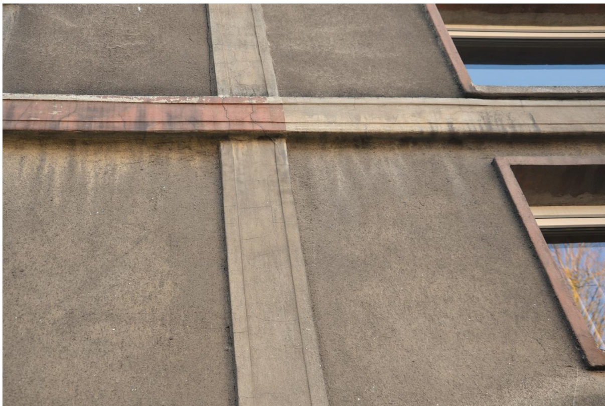
Fot. nr 18. Pęknięcia wyprawy tynkarskiej na powierzchni ścian, gzymsów i pilastrów [1.3.]
