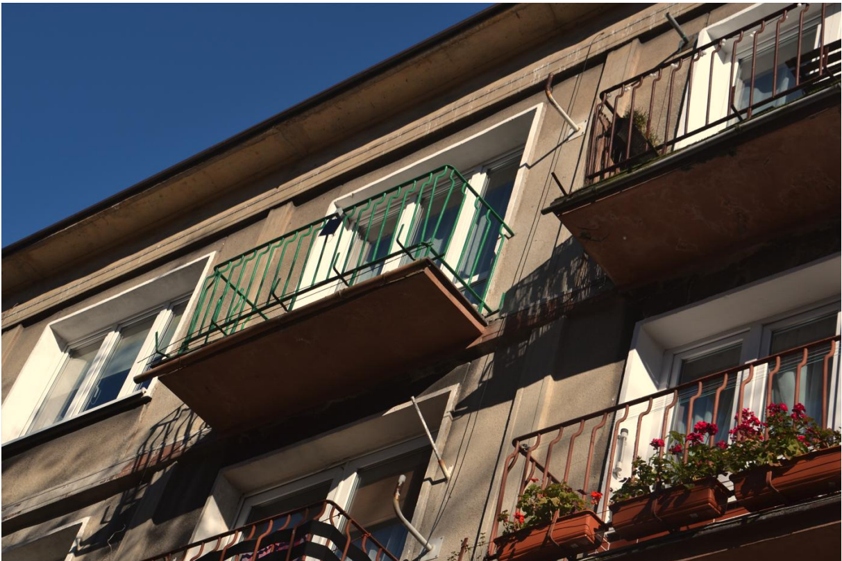
Fot. nr 12. Balkony na elewacji południowo – zachodniej, widoczne ślady zawilgocenia na spodach płyt balkonowych [1.3.]
