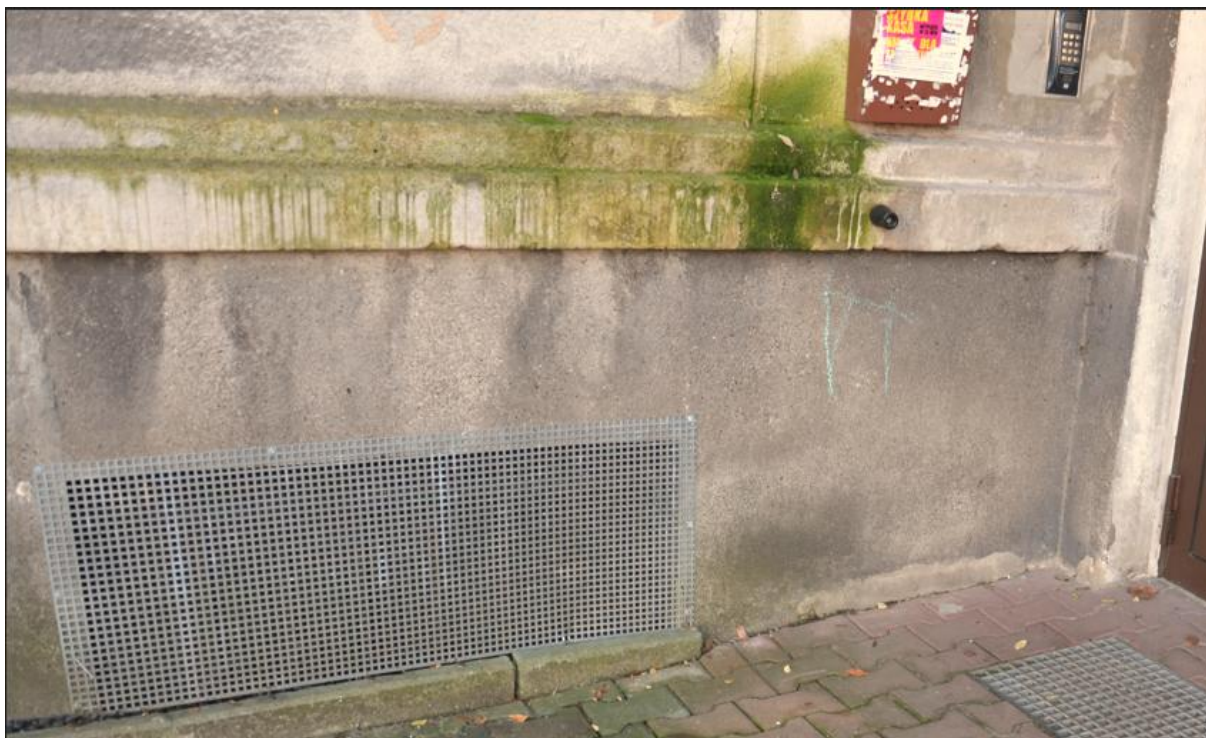
Fot. nr 7. Wewnętrzny, północny narożnik budynku – widoczne algi [1.3.]
