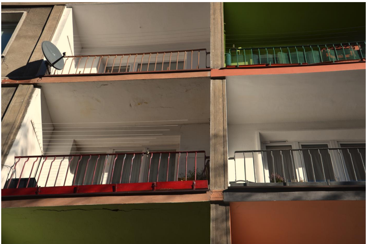
Fot. nr 14. Loggie na elewacji południowo – zachodniej, widoczne pęknięcia tynków na spodach płyt loggii, ślady zawilgocenia na spodach płyt [1.3.]
