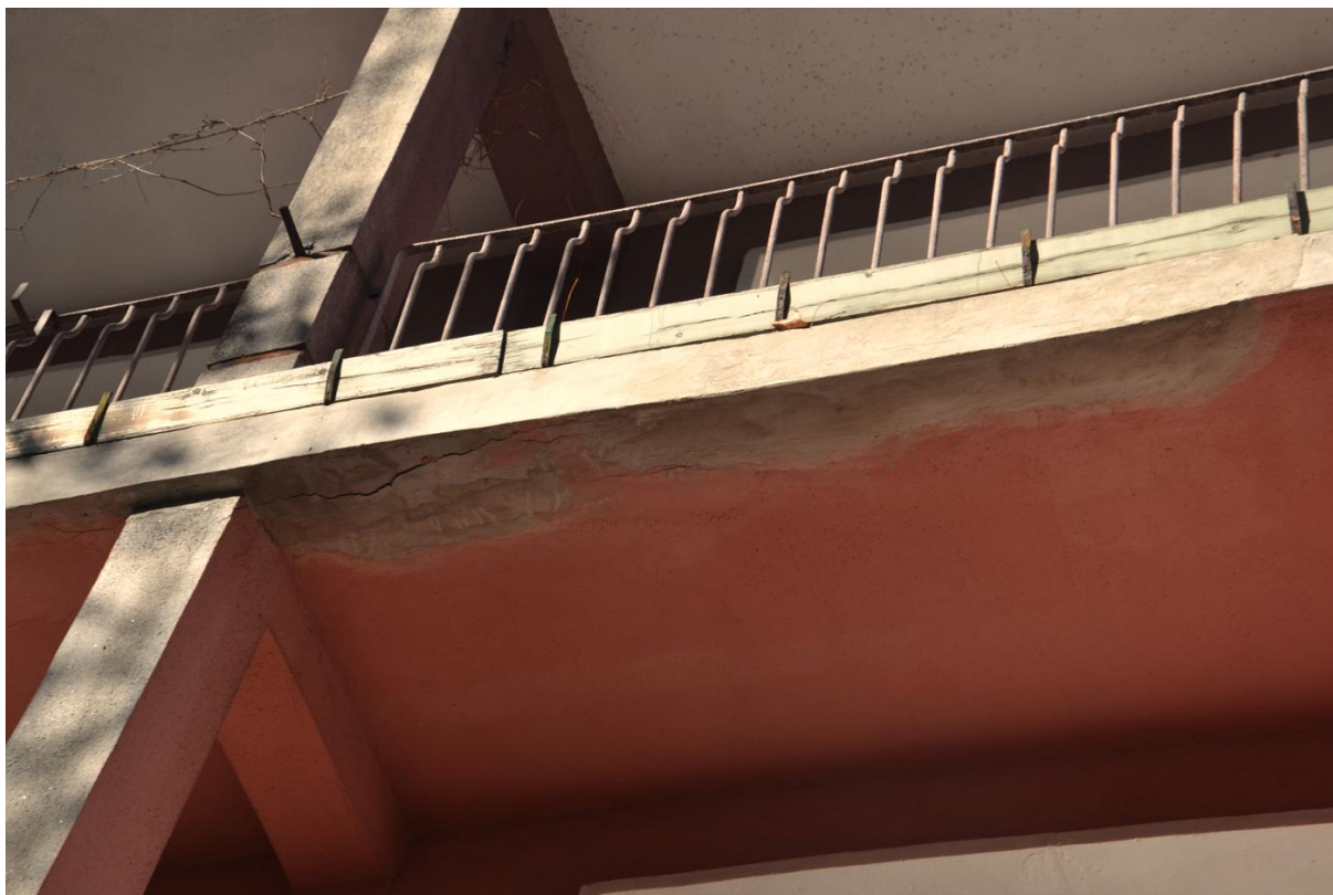
Fot. nr 10. Widok spodu loggii – brak krawędzi okapu płyty poziomej loggii, pęknięcia tynków wzdłuż okapu na widoczne na spodzie płyty [1.3.]
