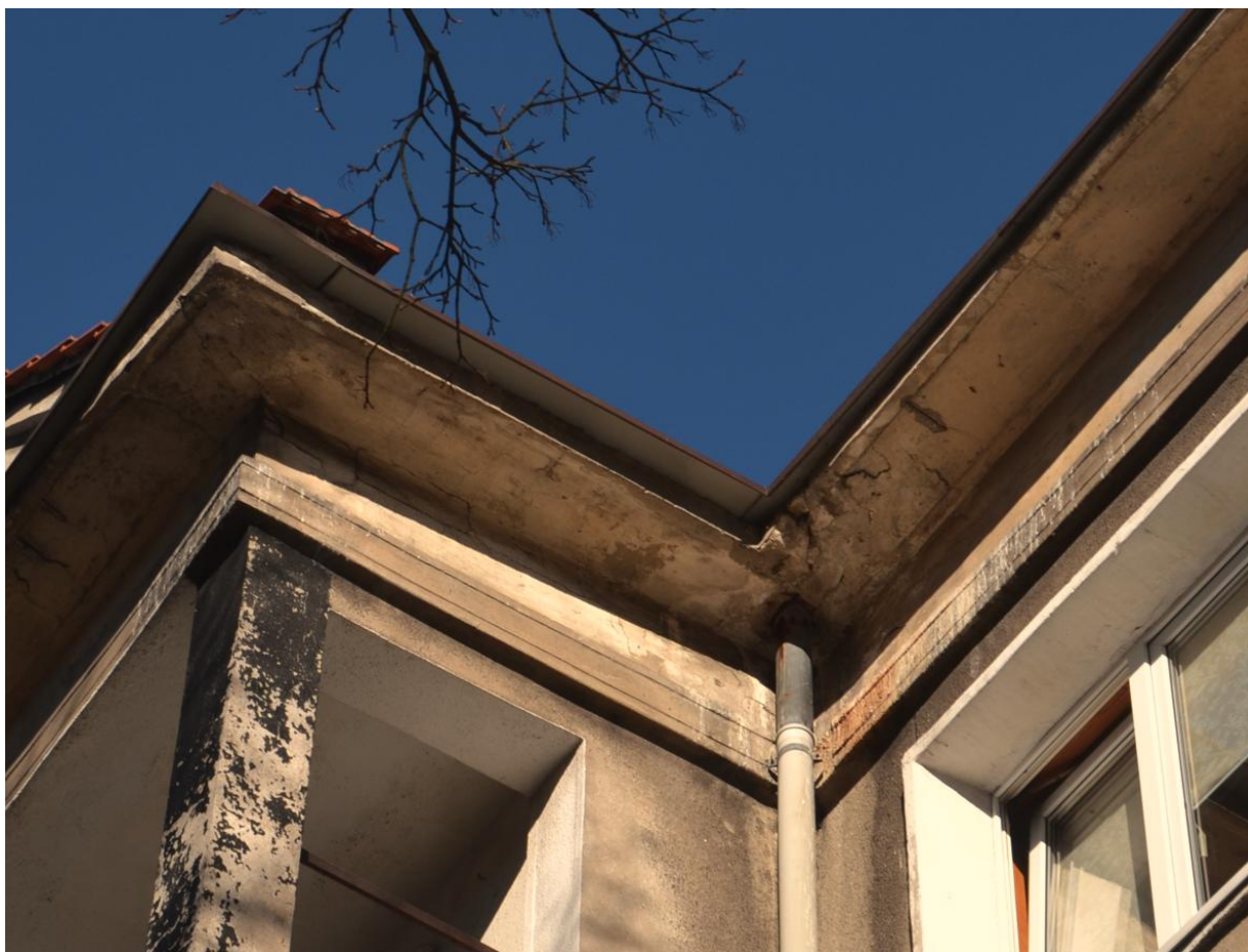
Fot. nr 16. Uszkodzenia gzymsu dachowego w obrębie przejścia rury spustowej – złuszczenie, ubytki betonu i odspojenie prętów zbrojeniowych [1.3.]
