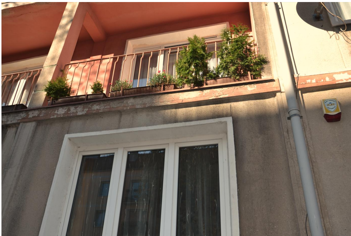
Fot. nr 9. Fragment elewacji południowo – wschodniej – widoczne pęknięcia i zabrudzenie tynków na gzymsach, ubytki powłok malarskich, ogólne zabrudzenie elewacji [1.3.]
