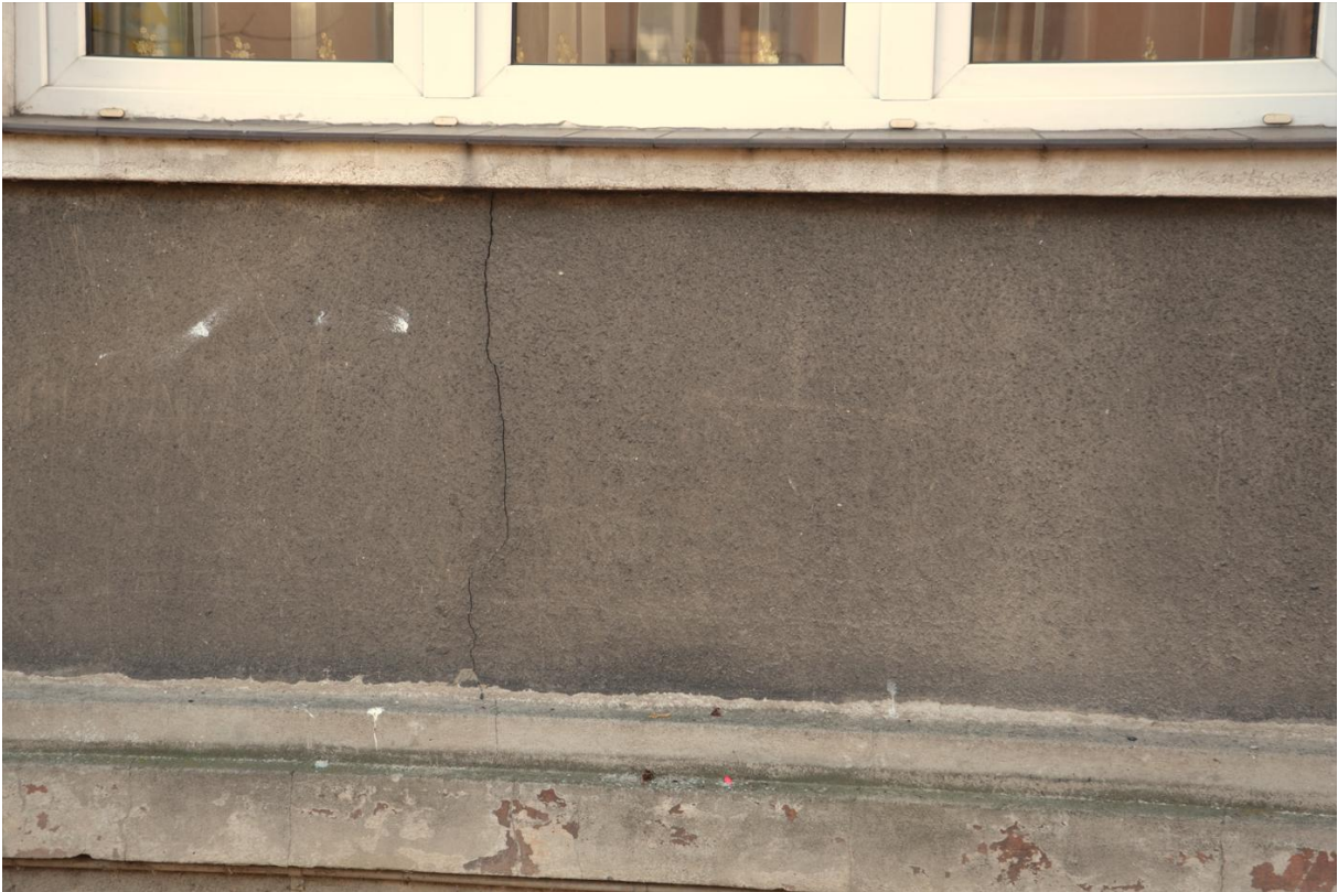
Fot. nr 11. Pionowe pęknięcie tynków ściany podparapetowej, ubytki powłoki malarskiej na powierzchni gzymsu cokołowego [1.3.]
