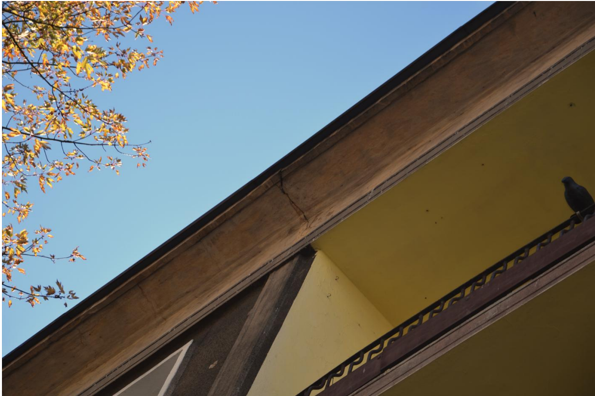
Fot. nr 19. Lokalne pęknięcie gzymsu dachowego – elewacja północno – wschodnia [1.3.]
