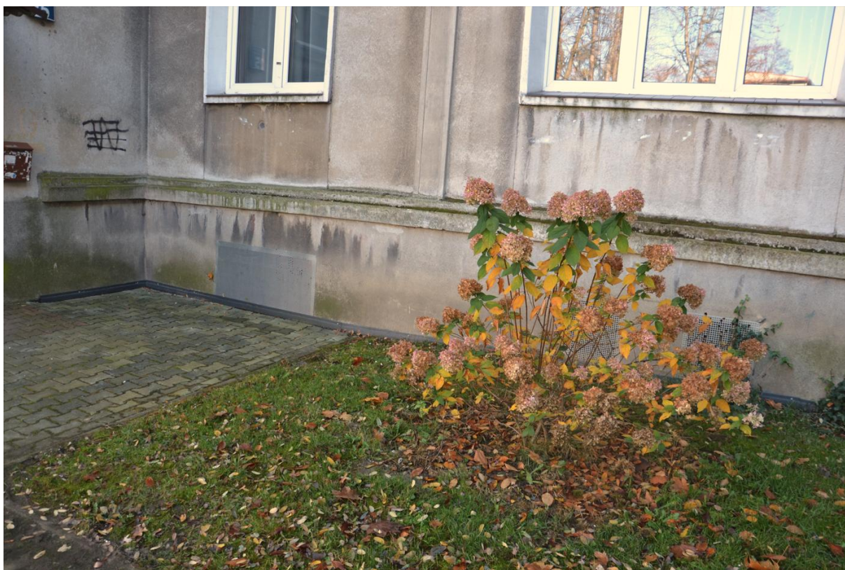
Fot. nr 6. Wewnętrzny, wschodni narożnik budynku – widoczne zabrudzenia elewacji, porażenie algami i mchem [1.3.]
