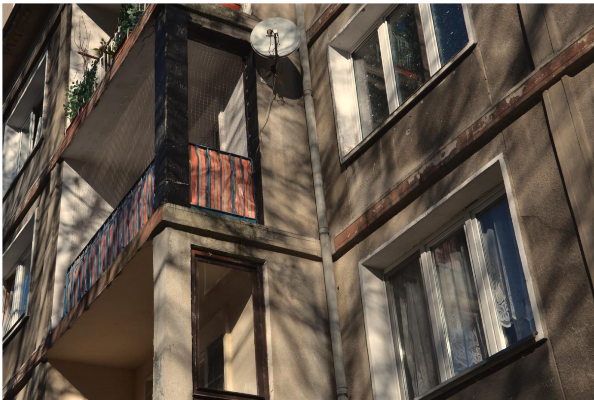
Fot. nr 15. Odspojenia, pęknięcia i ubytki tynków na powierzchni elewacji, odspojenie powłoki malarskiej na gzymsach międzypiętrowych [1.3. Błąd! Nie można odnaleźć źródła odwołania.]
