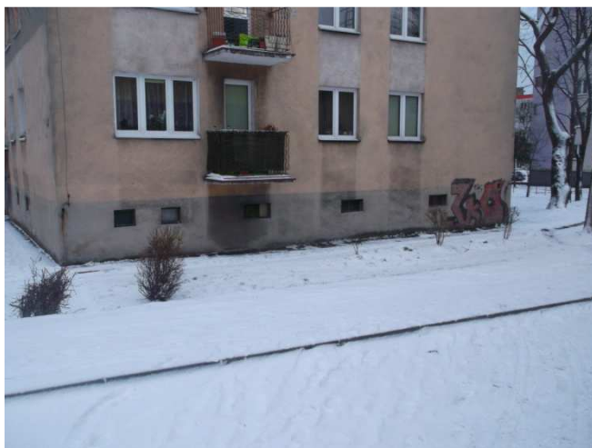
Fot.4. Elewacja południowo-zachodnia
