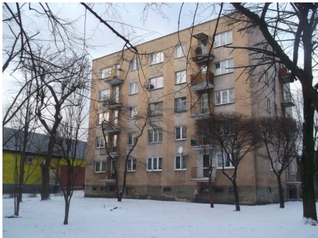
Fot.2. Elewacja północno-zachodnia
