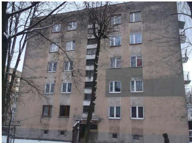
Fot.1. Elewacja południowo-wschodnia
