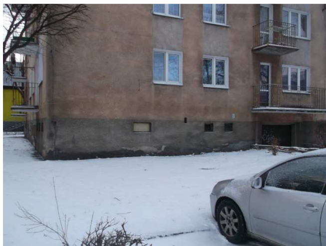
Fot.3. Elewacja północno-wschodnia
