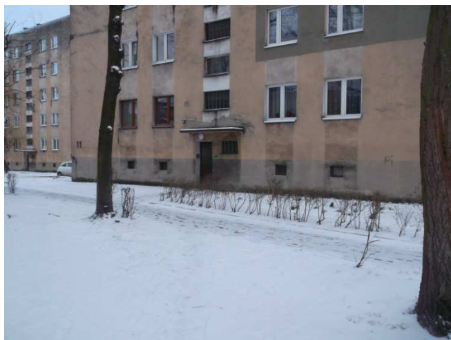
Fot.5. Klatka schodowa
