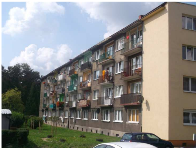
Fot.2. Elewacja południowo-wschodnia
