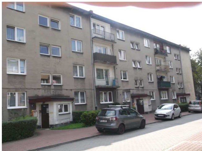
Fot.1. Elewacja północno-zachodnia
