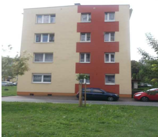
Fot.3. Elewacja północno-wschodnia (ocieplona)
