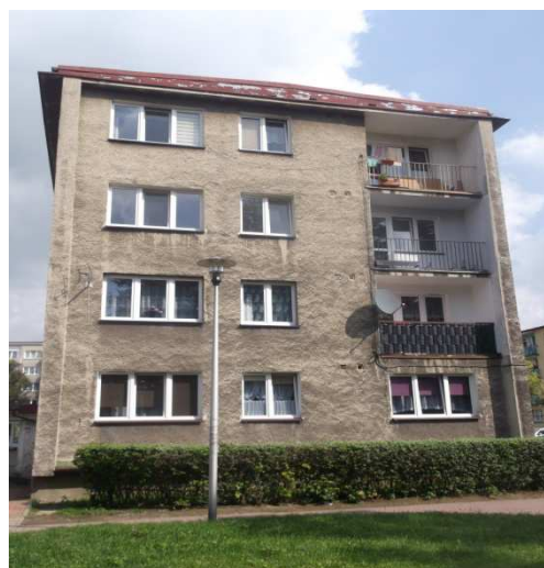
Fot.4. Elewacja południowo-zachodnia
